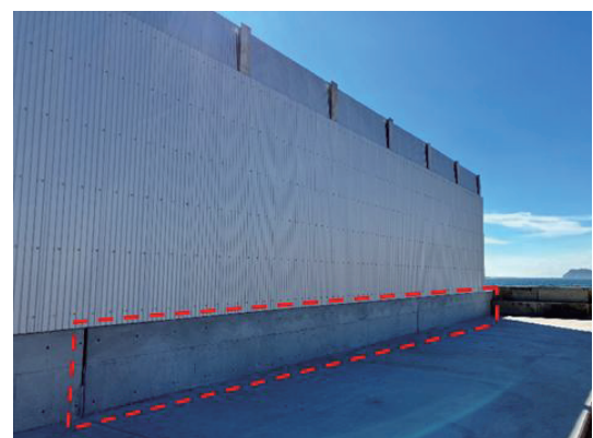
写真-3 完成した防潮壁 (赤破線枠が BiSCo)
