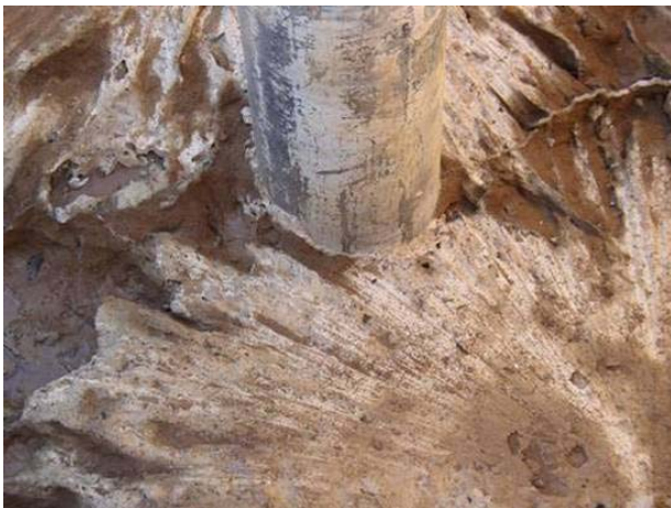
写真-2 補強体掘削状況 (杭周囲の状況)
