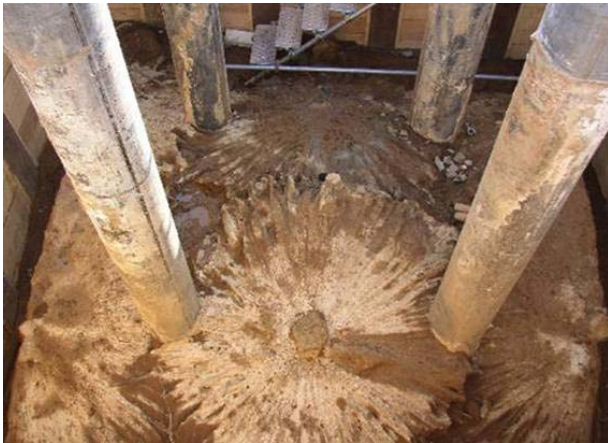
写真-1 補強体掘削状況 (上側から撮影)
