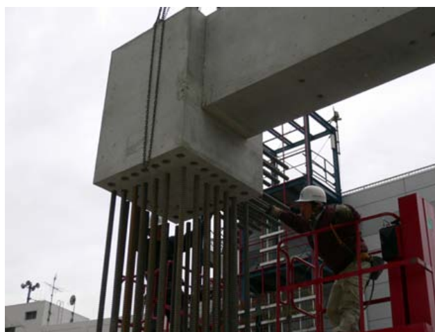
写真2 梁PCa建方（芯筋無し）
