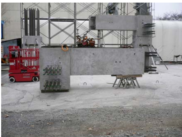
写真13 仮置き時架台
