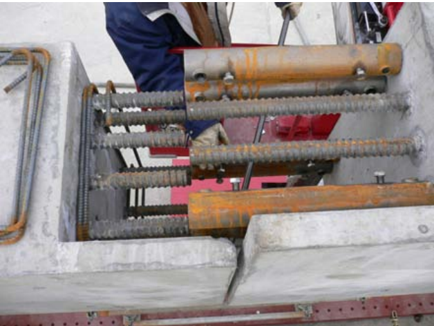
写真 17 コンクリート欠き込み長さ
