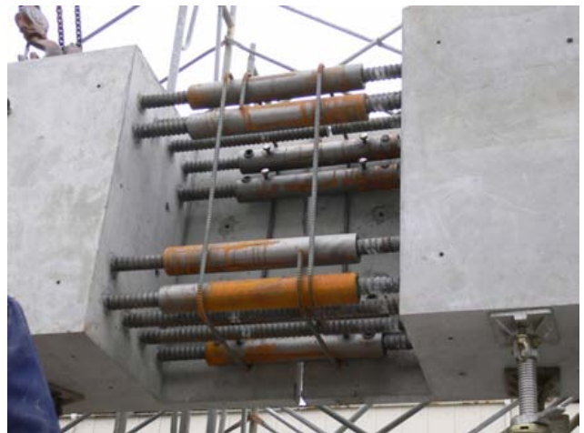
写真10 ボルトトップス継手
