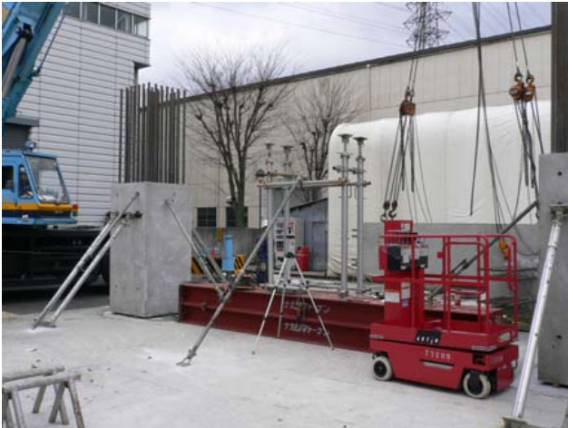
写真3 梁PCa用支保工
