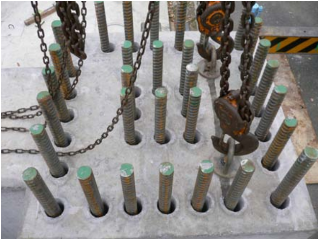
写真 15 吊り上げ金物（貫通後）
