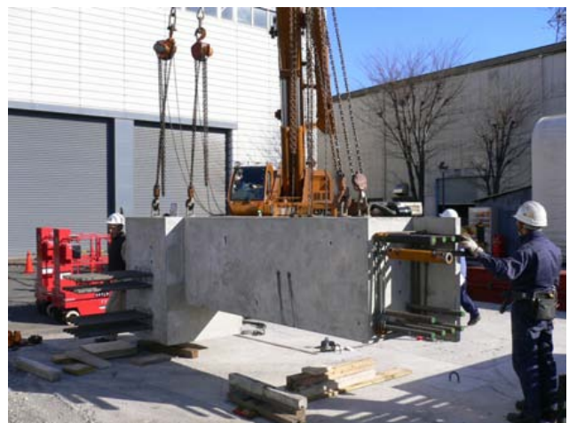
写真12 建方時吊り上げ方法
