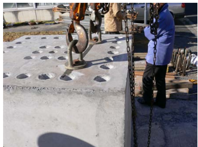
写真14 吊り上げ金物（貫通前）
