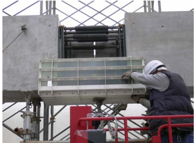
写真 16 ジョイント部型枠
