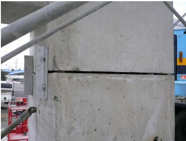
写真5 接合部平面位置調整用プレート
