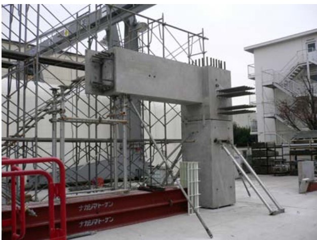
写真7 梁ジョイント部PCサポート
