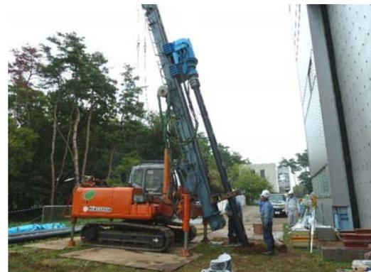
写真1 斜杭の施工状況
