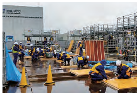
施工実習の風景
