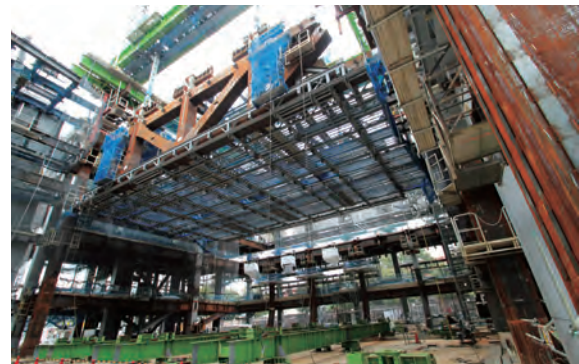
リフトアップ工法での施工の様子
