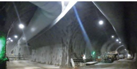
二重峠トンネルの建設現場
